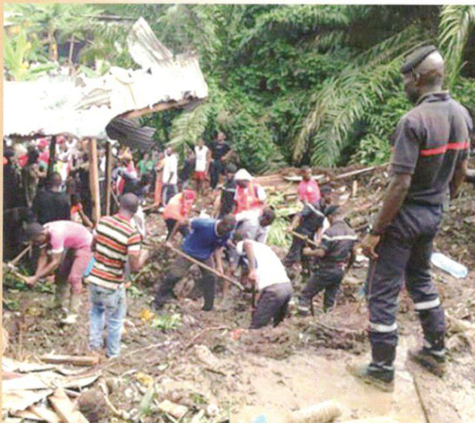
Intervention des Sapeurs-pompiers à la suite d'un éboulement à Yopougon qui a fait 03 morts le 27 mai 2019.
