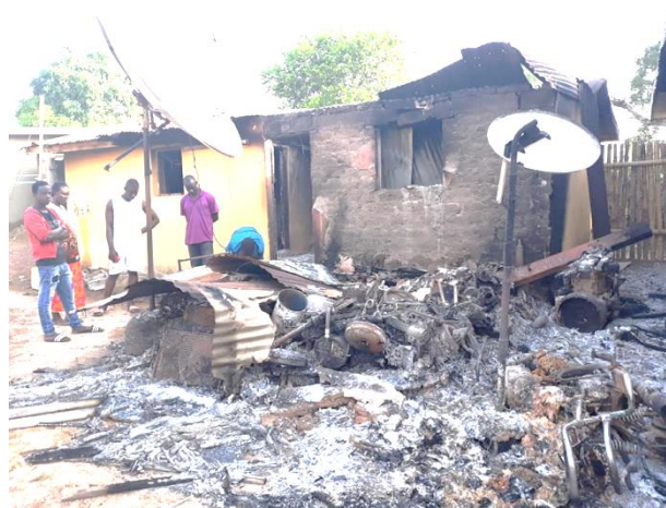
Habitation détruite par des jeunes lors du conflit intercommunautaire à Bin-Houyé du 31/03/2019
