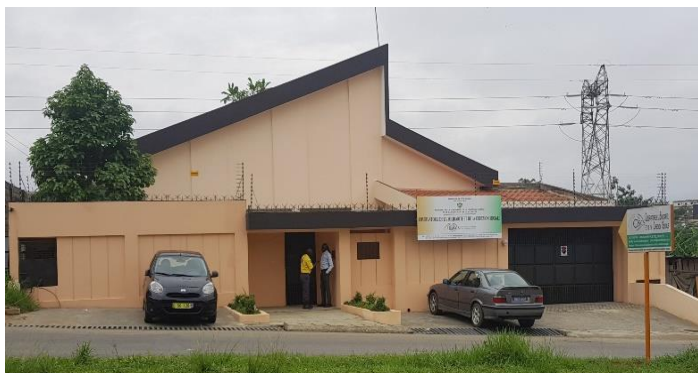
Le bâtiment abritant le siège de l'OSCS
