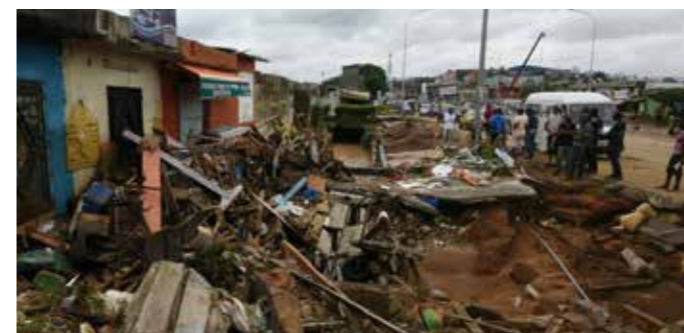
Dégâts provoqués par les inondations sur le Bvd. Mitterand au niveau d'Orca-Déco
